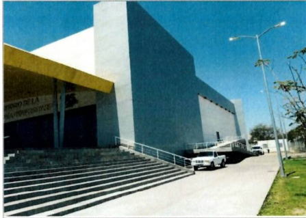
Fachada lateral derecha iluminación exterior.
