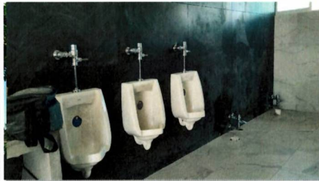
Cimbrado de fosa
