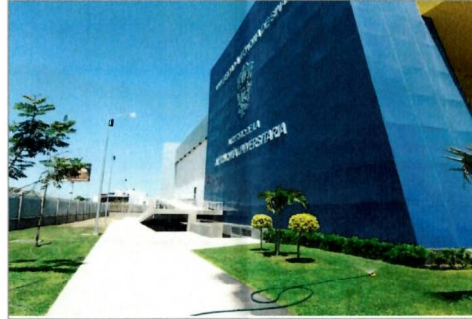
Fachada lateral izquierda iluminación exterior.
